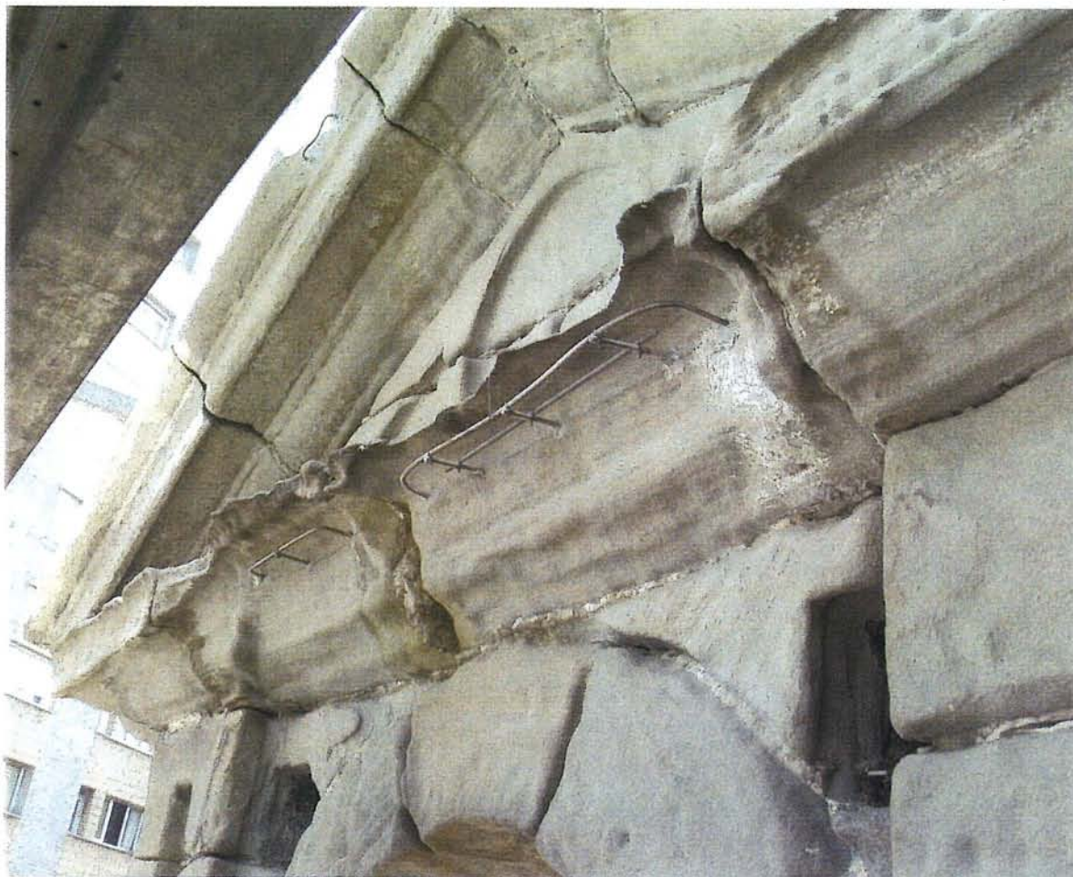
Figura 10: Armado de la cornisa de la espadaña. Figure 10. Framework of the belfry cornice.
