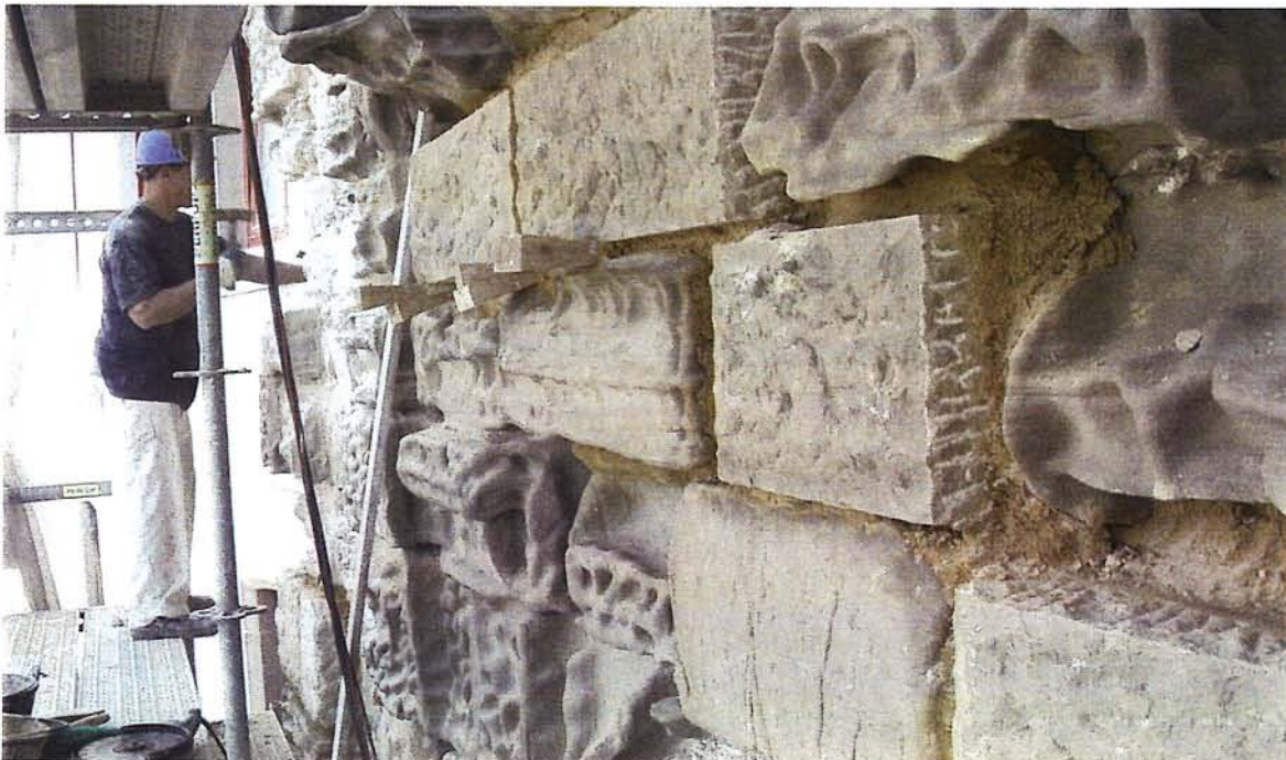
Figura 8: Labores de reposición con piedra en el cuerpo central de la capilla. Figure 8. Stone replacement in the central section of the chapel.
