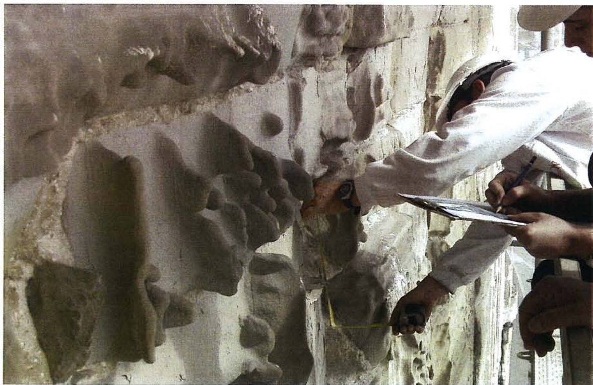
Figura 5: Evolución del fenómeno de alveolización hasta la pérdida de sección de los sillares. En estos casos sólo permanecen unas crestas de arenisca donde antes había un volumen continuo de la misma.
