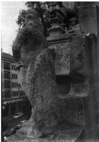
Fig. 7. Aspecto de la erosión producida en una escultura junto al escudo central. Nótese la presencia de fisuras.
