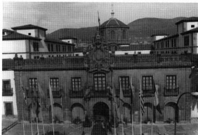
Fig.1. Aspecto de la fachada del antiguo Hospicio Provincial de Oviedo (actual Hotel de la Reconquista).
