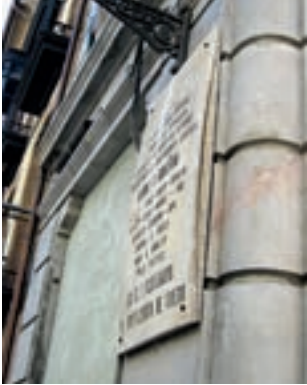
4.1. Combadura en una placa de mármol. Calle Cimadevilla, Oviedo (Asturias), 2009.
