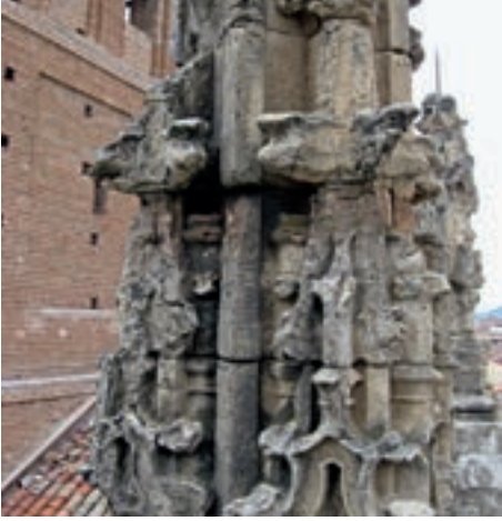
4.9. Cuarteado en una caliza margosa. Terraza en el convento de Santa Clara, Tordesillas (Valladolid), 2007.
