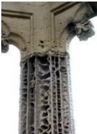
1.5. Alveolización muy acusada en una arenisca. Fachada norte del palacio de Sobrellano, Comillas (Cantabria), 2007.
