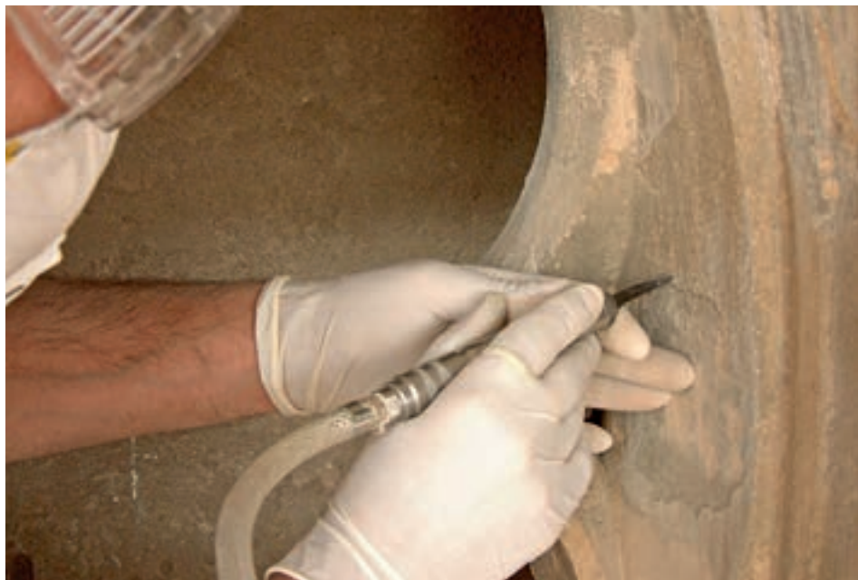
Figura 27. Eliminación de cementos con micropercutor.
