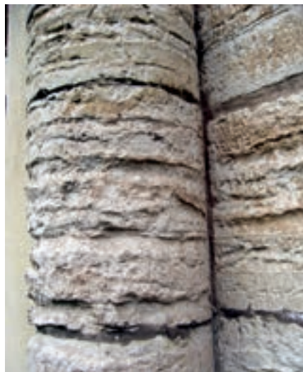
1.6. Acanaladuras en la dolomía micrítica de Laspra. Ábside en la iglesia de San Juan de Prio, Las Caldas (Asturias), 2008.
