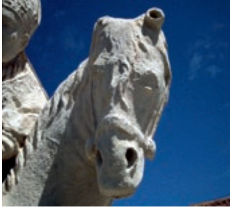
1.17. Disolución de la dolomía de Boñar. Escultura de la basílica de San Isidoro (León), 2011. 1.17. Dissolution on Boñar dolomite. Sculpture of basilica of St. Isidore (Leon). 2011.
