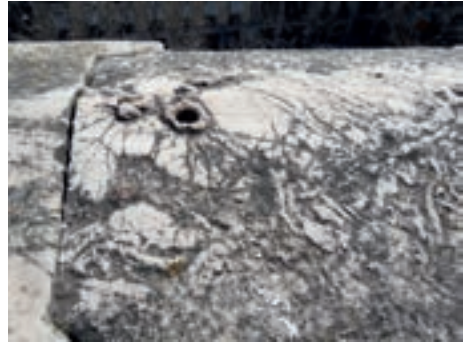
1.18. Disolución diferencial en una dolomía, con núcleos cristalinos resaltados y vetas disueltas. Balastrada de la Biblioteca Nacional (Madrid), 2010. 1.18. Differential dissolution on dolomite, with prominent crystal nuclei and dissolved streaks. Balustrade in the Biblioteca Nacional (National Library) (Madrid). 2010.
