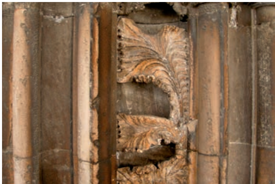
Figura 23. Limpieza con equipo láser de fibra óptica en la portada de la Almoina, catedral de Palma de Mallorca (Balears).
