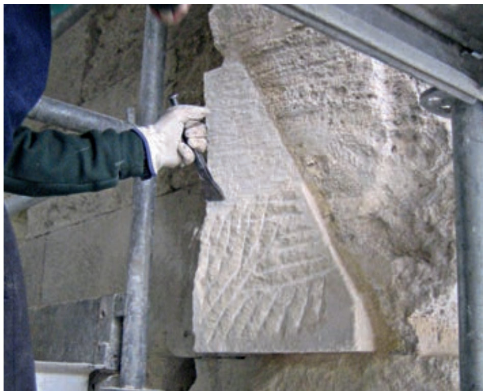
Figura 35. Reposición de un elemento en piedra natural.
