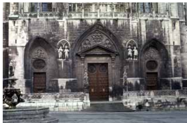
Figura 8. Influencia del diseño de la fachada en el deterioro de la piedra (caliza de Hontoria), en la fachada de Santa María de la Catedral de Burgos.
