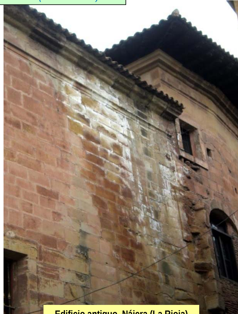
Edificio antiguo, Nájera (La Rioja)
