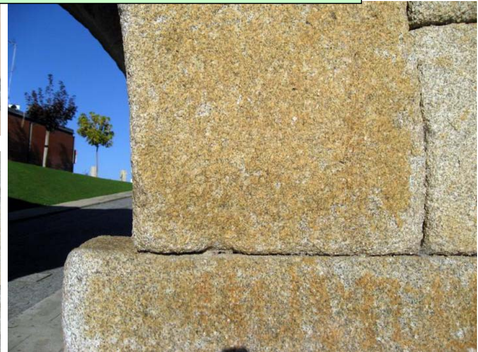
Muralla (Miranda do Douro)
