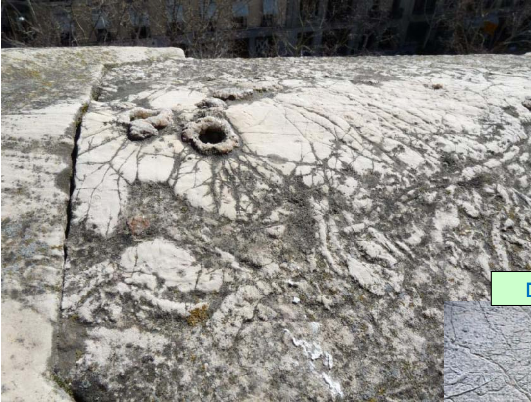
Balaustrada de la Biblioteca Nacional (Madrid)
