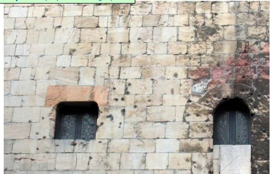
Casa de la Rúa, Oviedo (Asturias)
