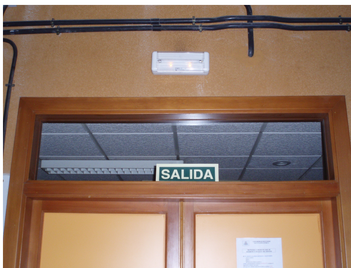
Figura 1. Puerta de acceso.
