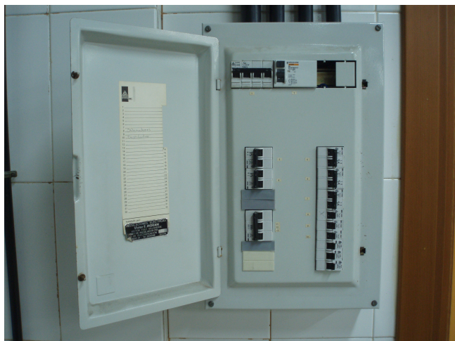
Figura 7. Izquierda: Detalle del cuadro de distribución. En la parte superior se encuentra el interruptor magnetotérmico de 63 A y el interruptor diferencial de 30 mA. Las dos columnas verticales son los interruptores magnetotérmicos de las líneas auxiliares. Derecha: Ubicación en el laboratorio (al lado de la puerta 071) del cuadro de distribución.
