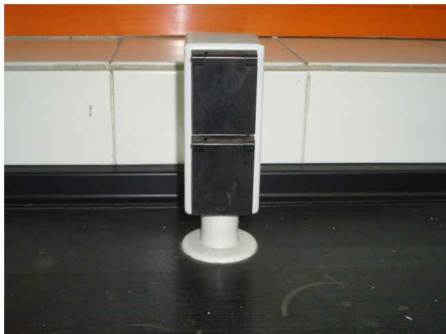
Figura 6. Izquierda: Bases en torreta sobre la mesa de trabajo experimental de madera. Derecha: Bases encastradas en canaleta sobre la mesa de trabajo experimental de gres.
