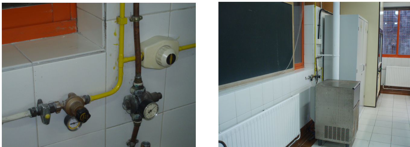
Figura 5. Izquierda: Llave de paso general del gas natural (a su derecha puede observarse una llave auxiliar). Derecha: Ubicación en el laboratorio (al lado del armario de seguridad) de la llave de paso general del gas natural.
